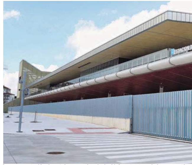
La nueva estación de autobuses es la principal infraestructura de las que están e
