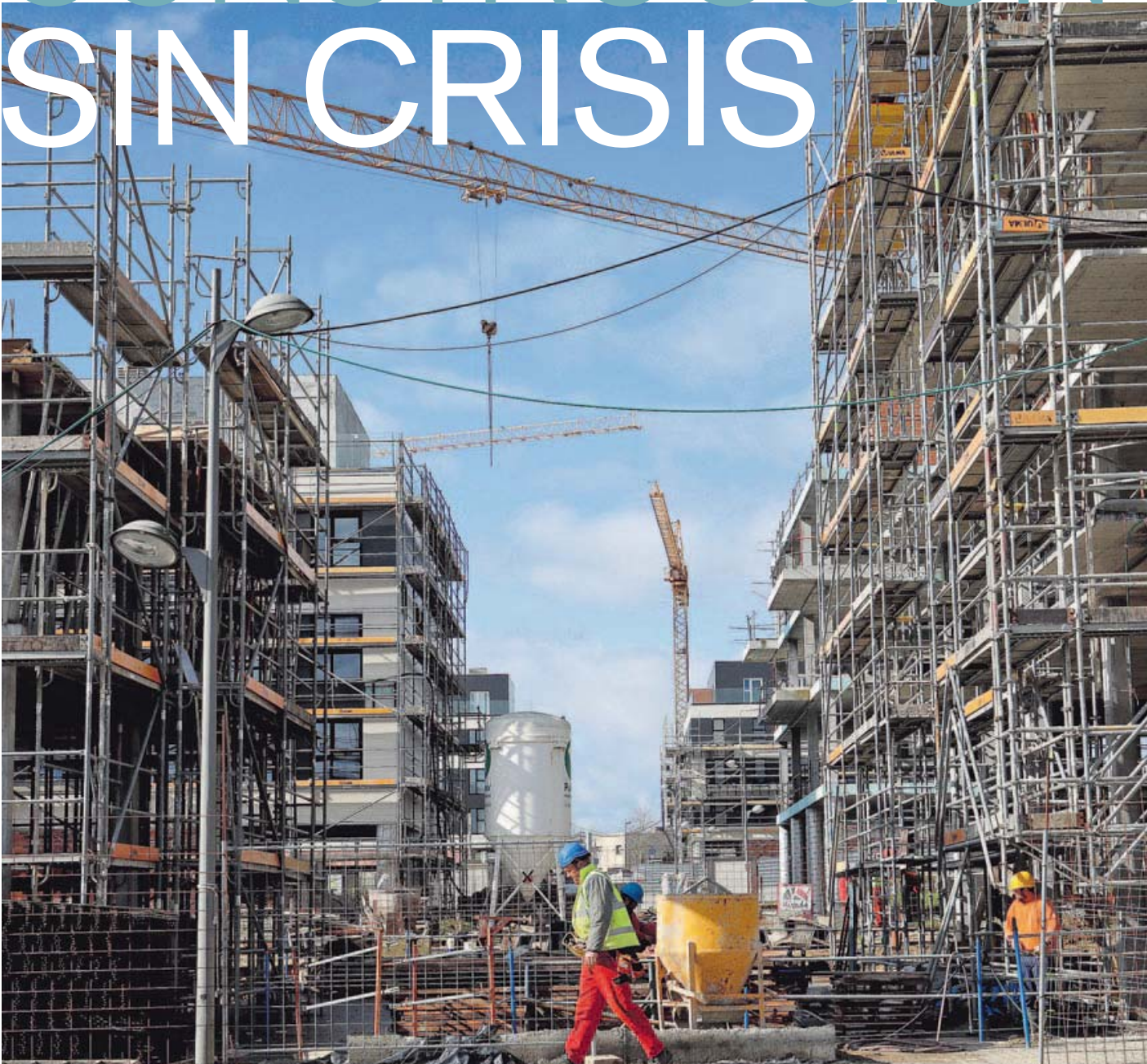
El sector de la construcción no se ha parado en Santiago y es el que mejor resiste la crisis del covid que afecta a todas las actividades económicas FOTO SANDRA ALONSO
